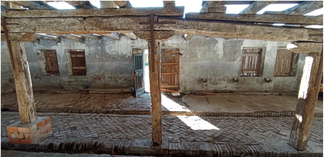
Lavori in Cascina Carpana
