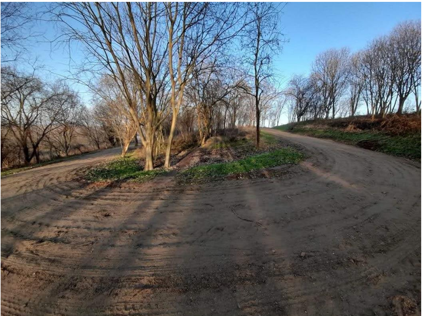
Livellamento strade per migliore percorribilità
