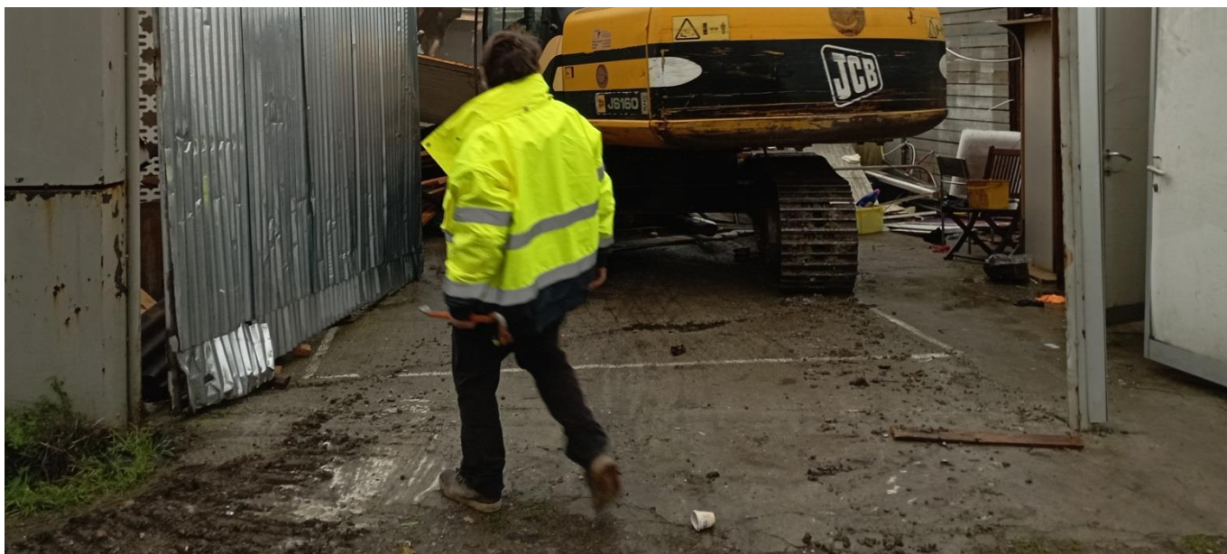
Avvio operazioni di recupero via San Dionigi 93
