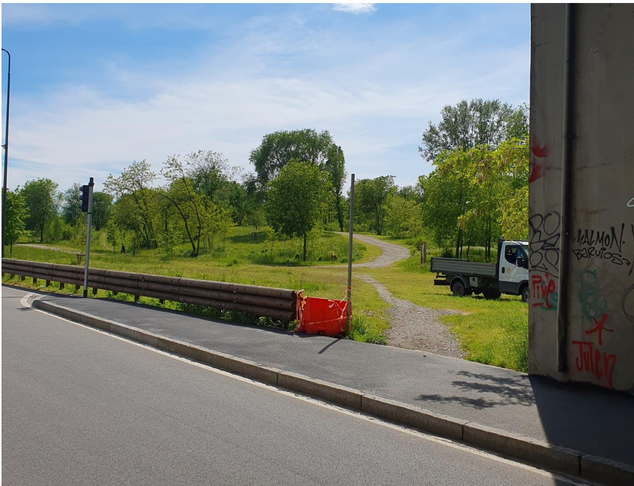
Marciapiede realizzato all'ingresso dalla stazione di Rogoredo
